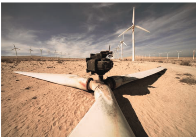
Les pales des éoliennes doivent être remplacées tous les dix ans environ.
